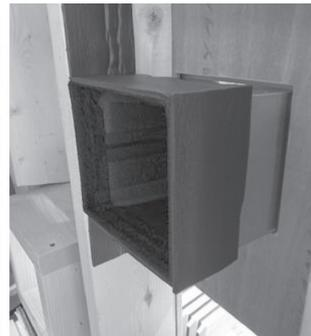
④側面に貼り付けると共に1枚を半分に切断し、固定金具部に貼り付けます。
